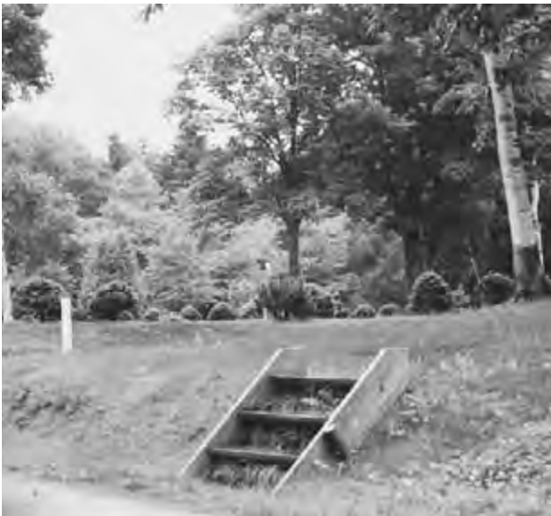
コースを点検し、白樺コースの危険箇所には階段ができました。
